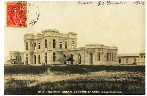
Construction de la gare de Da Nang 1906
