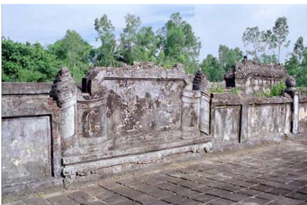
Tombeau de Duc Duc – mur d'enceinte
