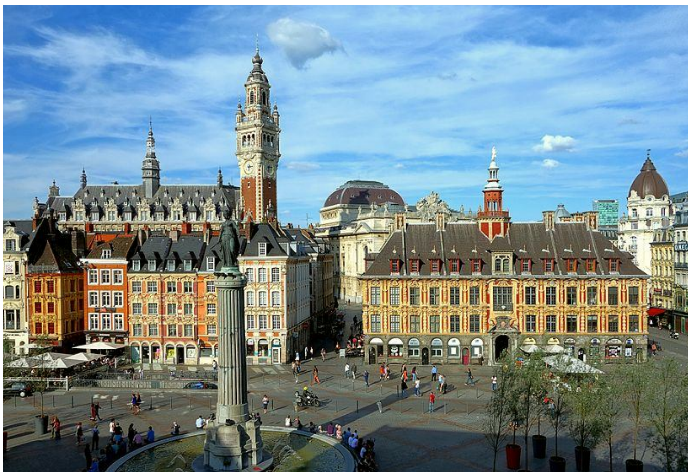
Place du GI de Gaulle (Grand' Place) ; à droite la Vieille Bourse, et au fond, le Beffroi faisant face à la coupole de l'Opéra
