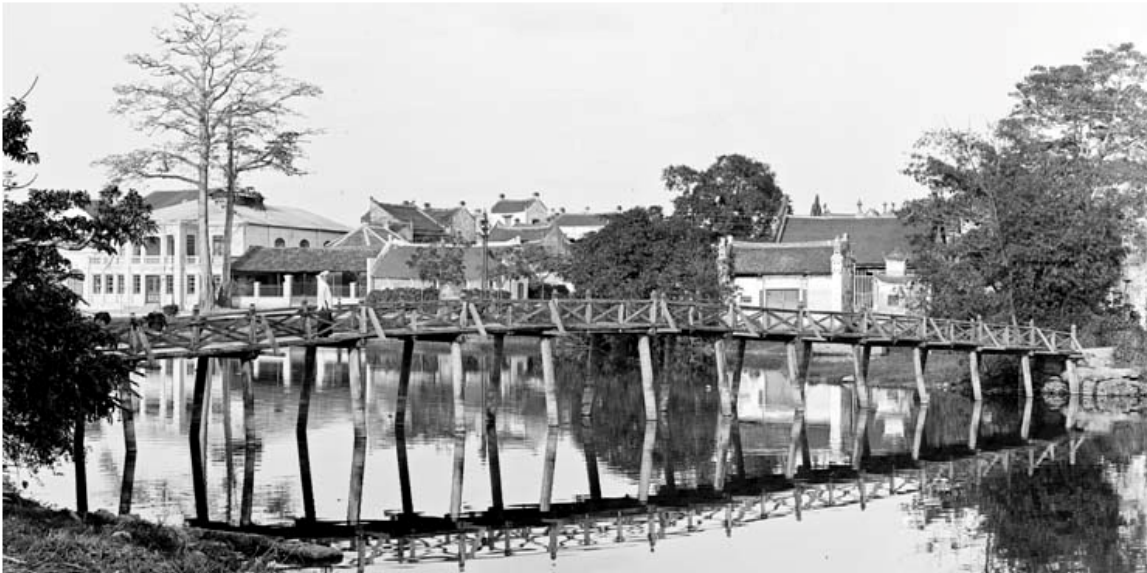
Hình 5, của Firmin-André Salles (1896), chi tiết. 12 năm sau, dùng một cái, cầu Thê Húc biến dạng, cong hơn trước, hai bên có lan can và cầu trúc đại khái như ngày nay. Chưa có hình màu, nhưng nhiều khả năng là cầu có màu sơn.
