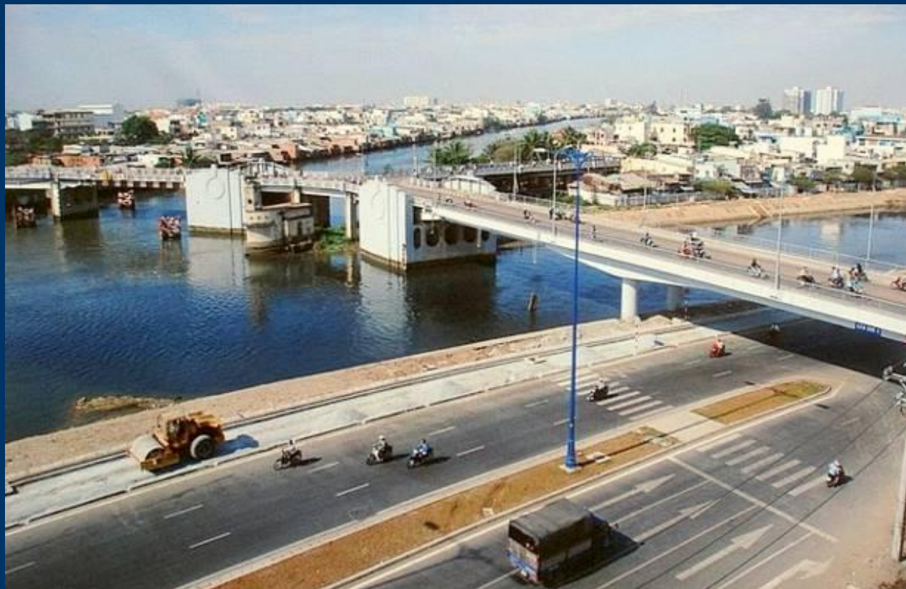
Pont en Y – Cầu chữ Y
