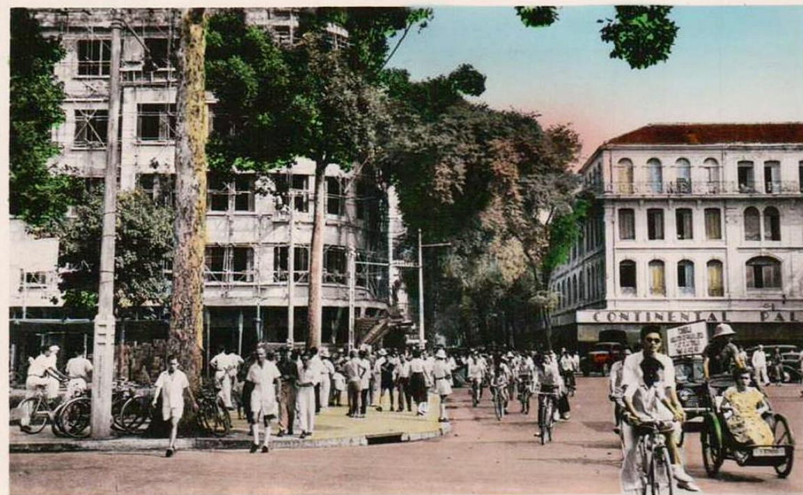
Thời điểm tòa nhà EDEN còn đang trong quá trình xây dựng, vẫn chưa hoàn tất – Góc bên phải là khách sạn Continental
