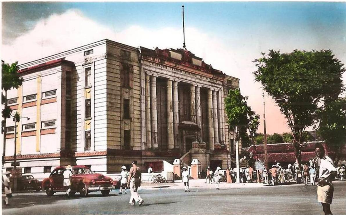
Trụ sở công ty xăng SHELL, góc Thống Nhất – Cường Để
