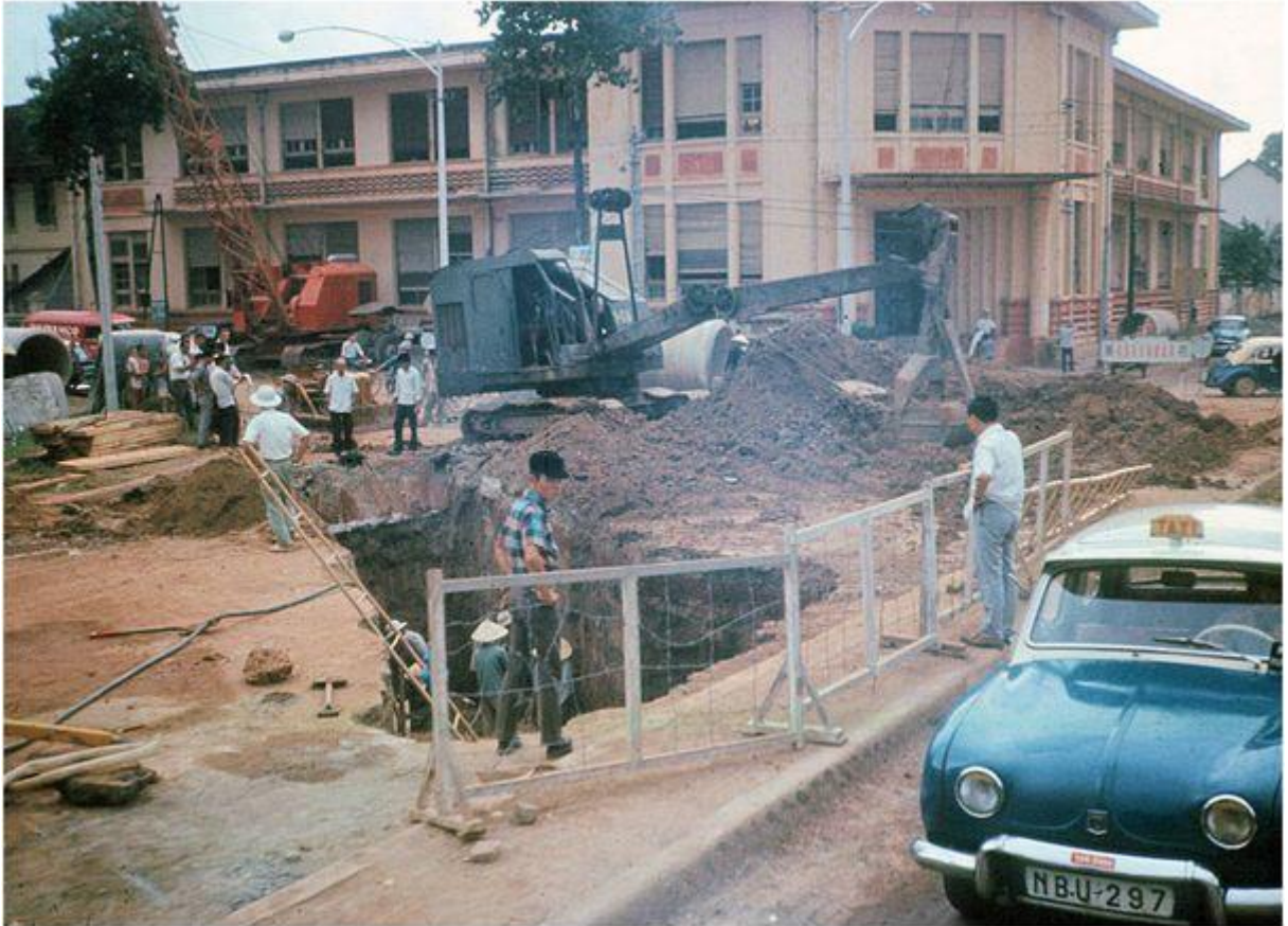
Lắp đặt đường ống nước tại góc đường Phan Thanh Giản (nay là Điện Biên Phủ) – Nguyễn Bình Khiêm.
