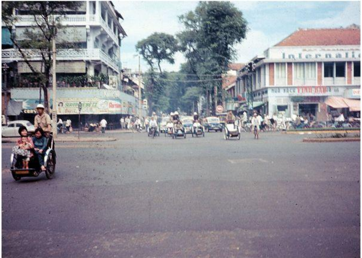
Ngã tư đại lộ Lê Lợi – đường Nguyễn Trung Trực.
