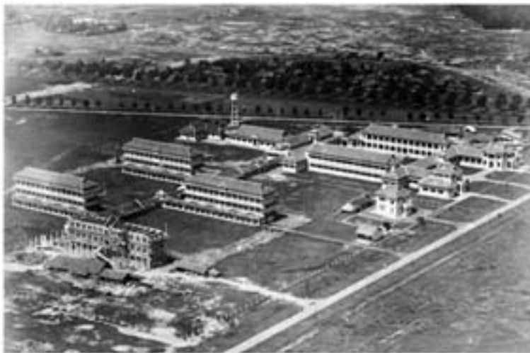
> Toàn cảnh trường Petrus Ký nhìn từ trên cao, thập niên 1920. Một số tòa nhà của trường thời điểm này đang được thi công.
